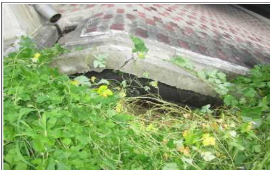
하행선 A2 법면 배수로 손상 및 하부 유실
